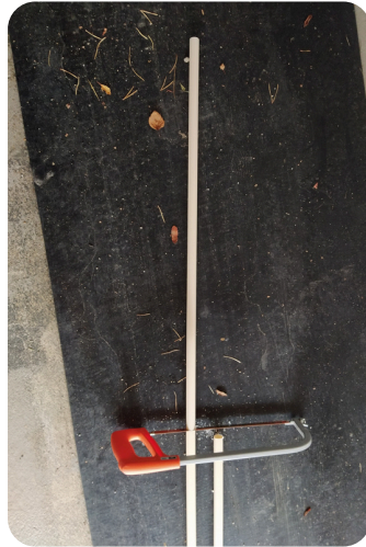
2. Sahaa muoviputkesta miekanmittainen pätkä
